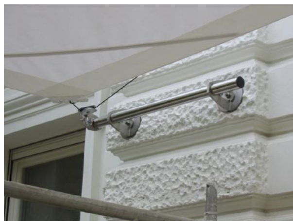
Abb.4: Fertige Montage einer Wandstütze - eine Verbindung von zeitgenössischem Design und historischer Fassade.
