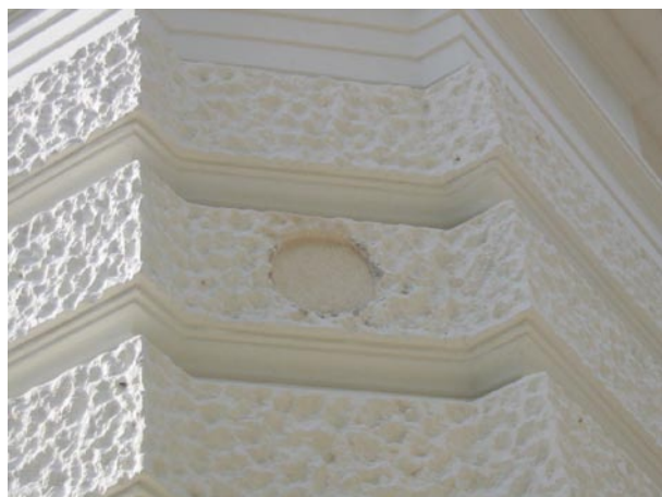
Abb.1: Ausfräsen der für die Montage notwendigen Bereiche ohne Zerstörung der umliegenden Fassadenstrukturen.
