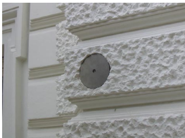
Abb.3: Setzen der Distanzscheiben für eine ebene Montageoberfläche und eine kraftschlüssige Verbindung.
