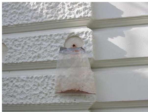
Abb.2: Bohren der Montagepunkte unter Rücksichtnahme und Verhinderung eventueller Verschmutzung der Fassade.
